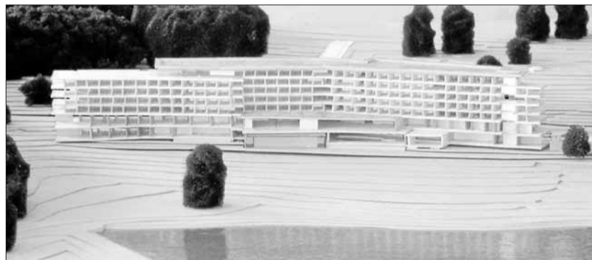
Das neue Rehaszentrum im Modell, hier von der „Seeseite“ des Schwarzenbacher Teichs (im Vordergrund) aus gesehen.
