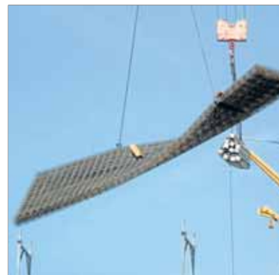
Schweben durch die Luft: Stahlmatten und andere schwere Baustoffe.
