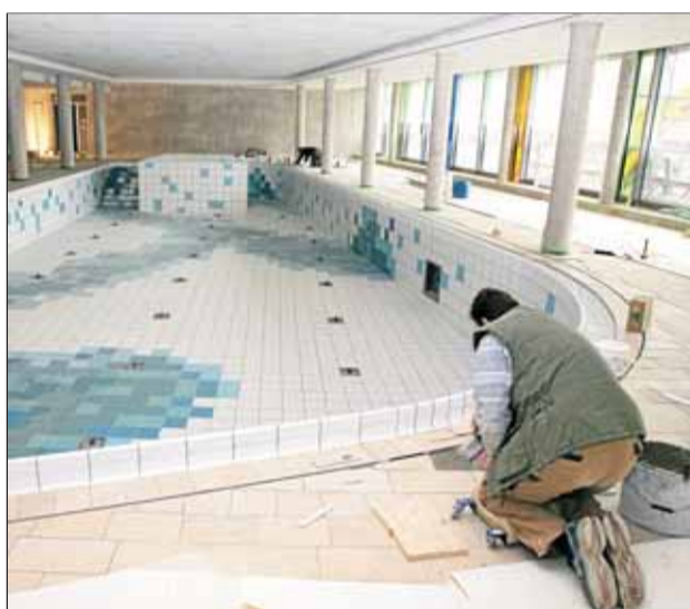
Fliesenleger im künftigen Bewegungsbad der Klinik Am Schwarzenbacher Teich: Bis zur Eröffnung am 8. Juli haben die Handwerker an Innenausbau und Einrichtung des mächtigen Baukörpers noch viel zu tun.
