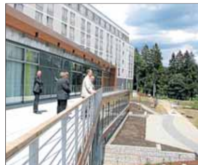
Zur Seeseite sind die meisten Zimmer und der Speisesaal ausgerichtet.
